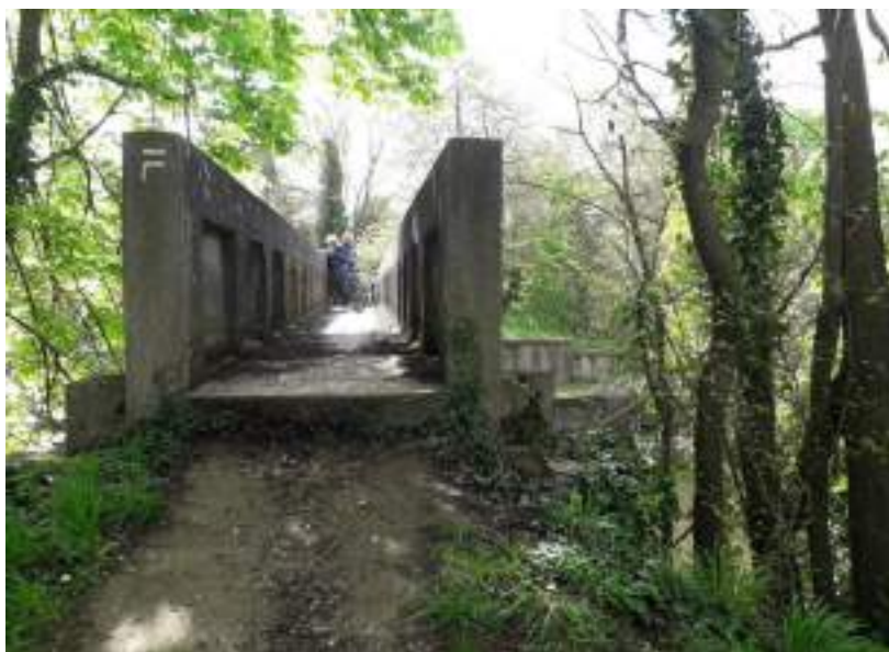
Photos rive droite – passerelle Eppeville
