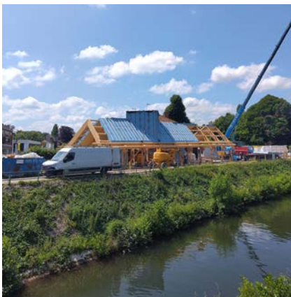
Construction du nouvel office de tourisme
