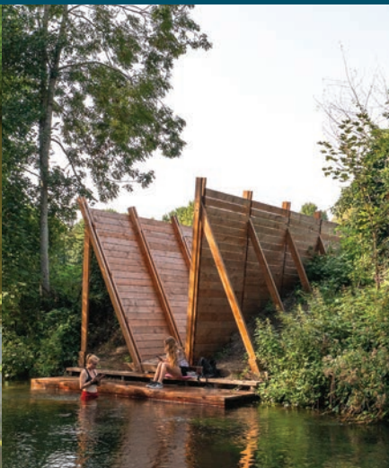
Le Déversoir à Pont-Remy
