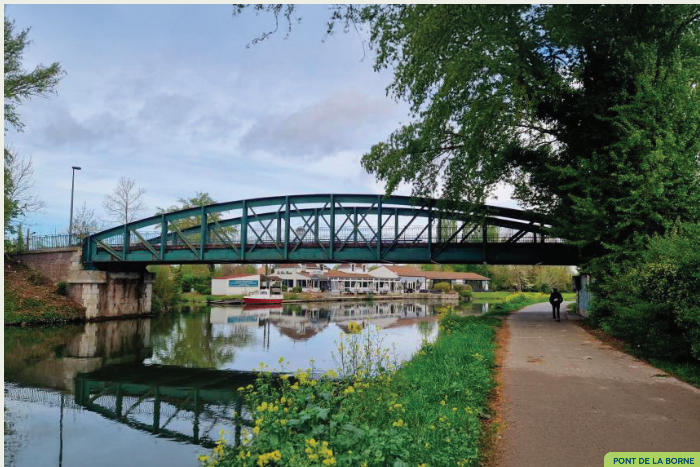
PONT DE LA BORNE
