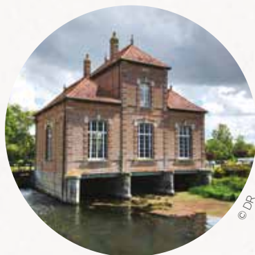
L'usine hydroélectrique : une vieille dame à remettre en fonction
