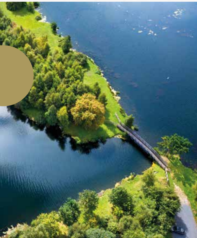
Passerelle des près à pions
