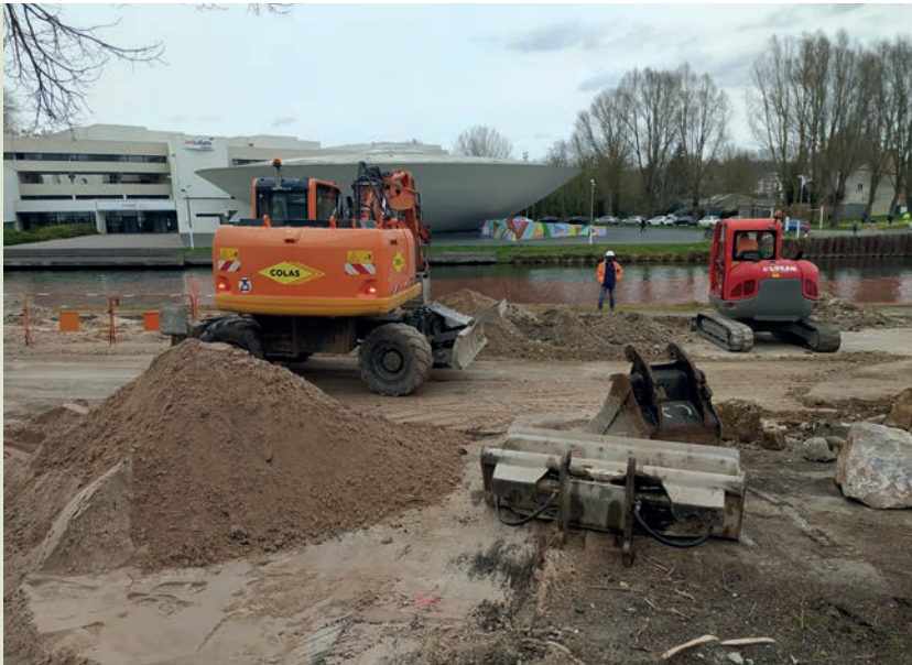
Travaux du Port d'Aval
