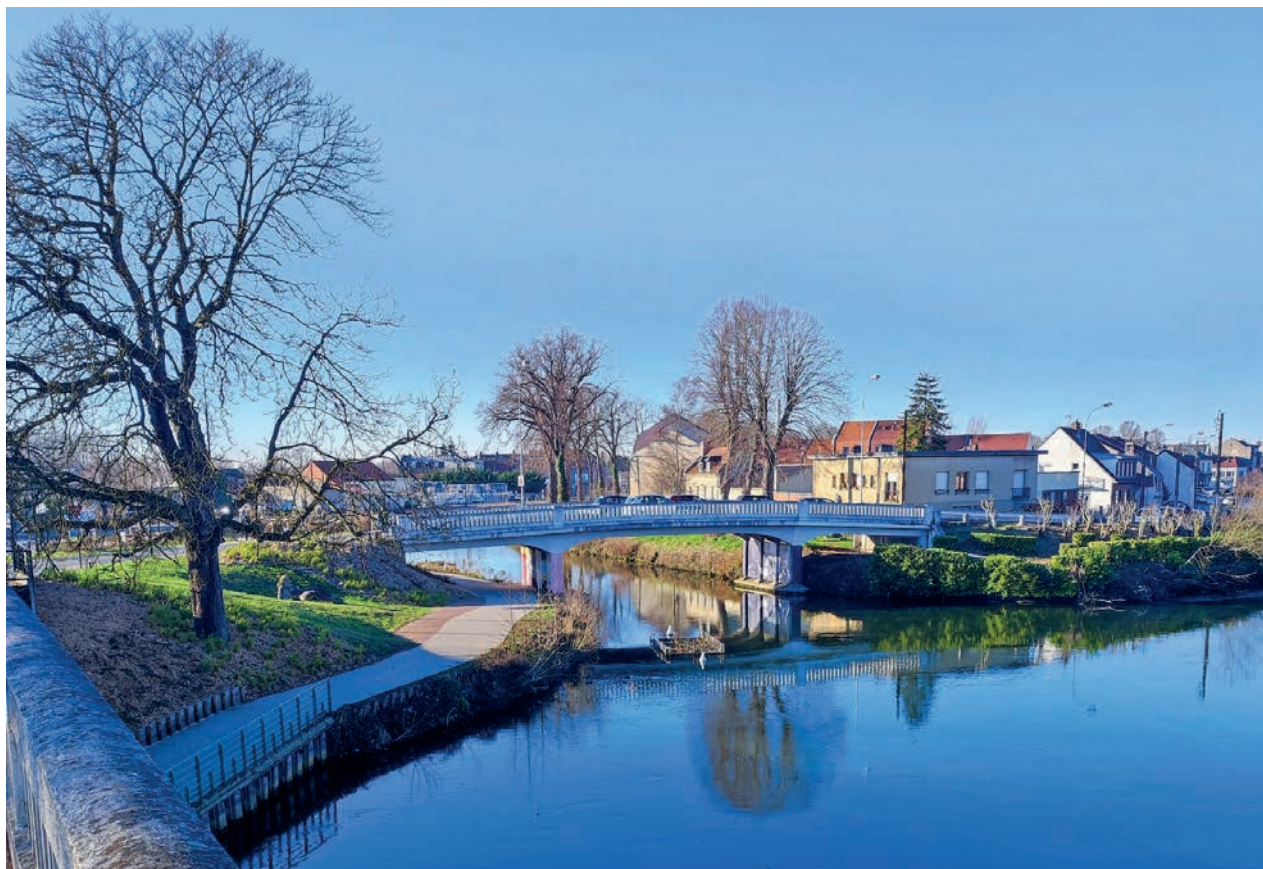
Aménagement réalisé autour du pont de la Portelette d'Abbeville
