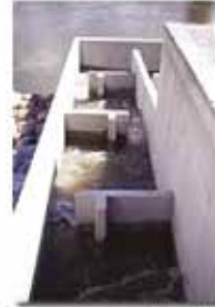
Exemple d'une passe à poisson (tiré du site de l'ADEME)
