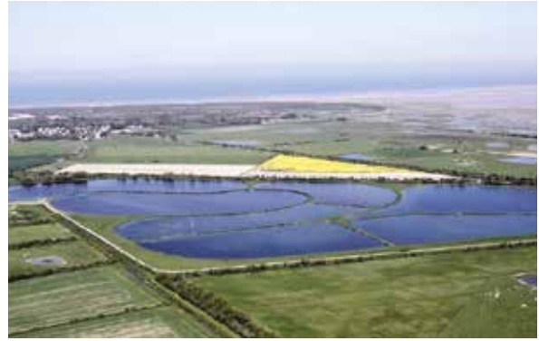
● La station d'épuration par lagunage de Fort-Mahon
