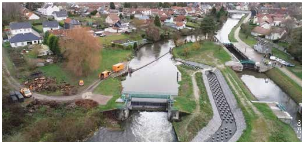
Rénovation de l'écluse et création d'une rivière artificielle à Pont-Rémy
