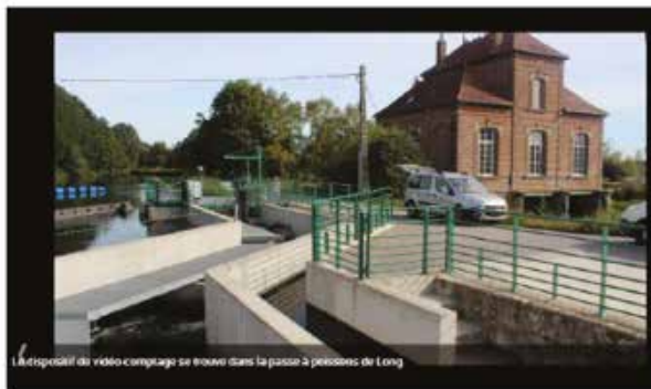
Le dispositif de vidéo-comptage installé à l'écluse de Long (extrait du Courrier Picard du 22 septembre 2018)
