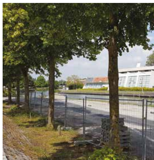
Le site du futur relais nautique à l'aval de l'usine Saint-Michel
