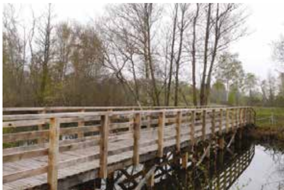
... ● Passerelle du Pré-à-Pions
